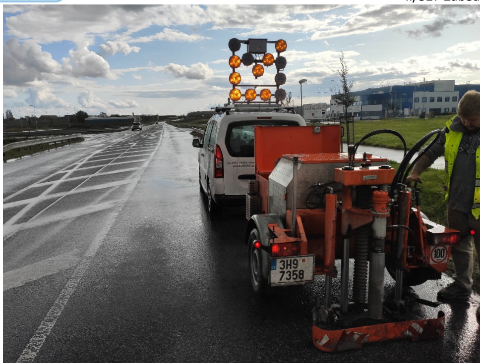
Vrtání vývrtu č.2
