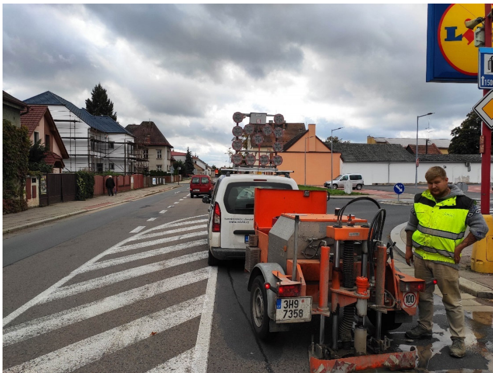
Vrtání vývrtu č.12
